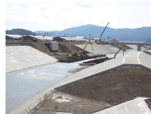
南三陸町の河川堤防
