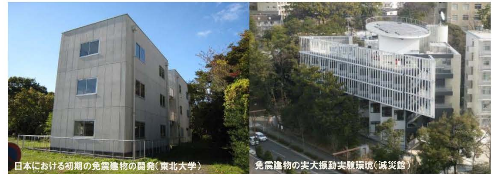
日本における初期の免震建物の開発(東北大学)
